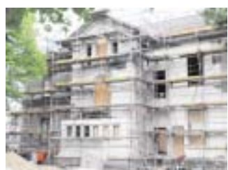
Die Villa aus dem Jahr 1885 wird saniert. I Foto: Geinowski
