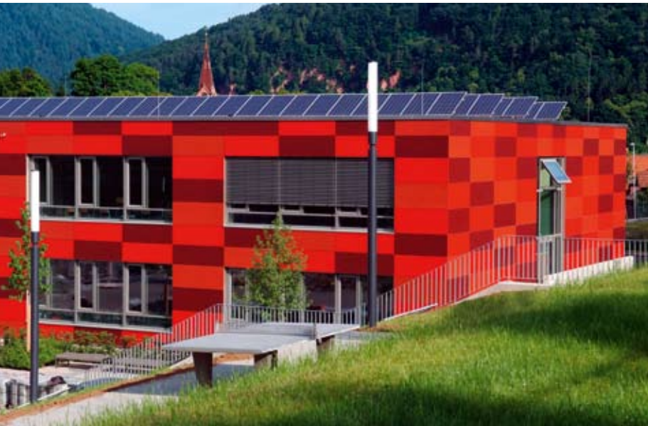
Das neue Schulzentrum in Neckargemünd wurde u.a. für seine moderne Energieversorgung, Sole-Wasser-Wärmepumpe und Holzpelletsessel mit dem 1. Preis ausgezeichnet
